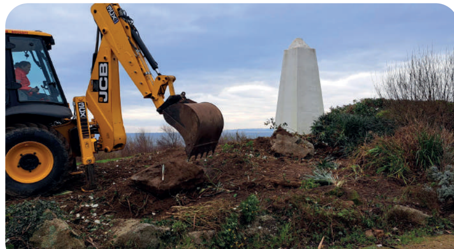
Arrachage mécanique à l'aide d'une pelleuse près de l'amer non loin de la chapelle Sainte-Barbe - 2025
