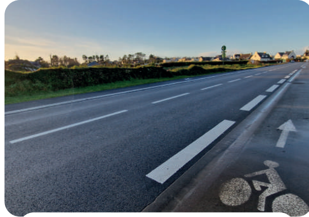
Route du car ferry refaite en 2025
