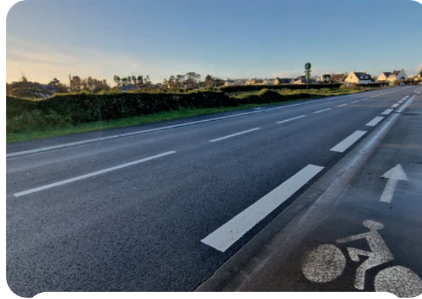
Route du car ferry refaite en 2025
