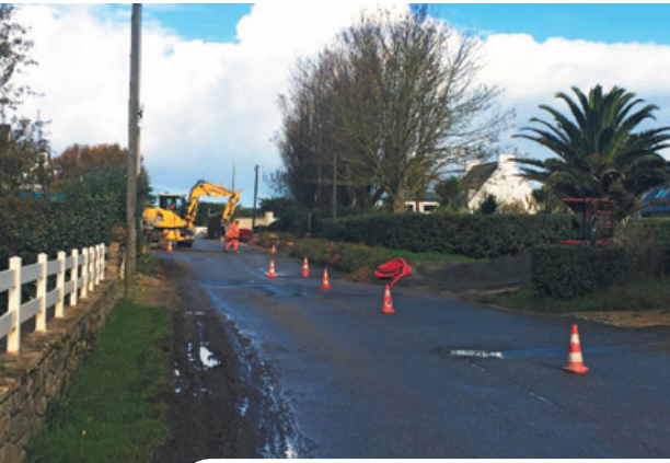
Route de Perharidy : les travaux de réfection et d'effacement des réseaux s'achèvent, reste l'aménagement de la voirie
