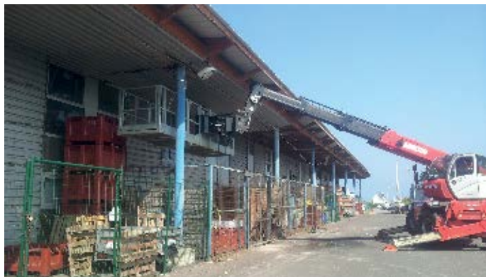
▲ La couverture et le bardage des ateliers relais ont été remplacés.
