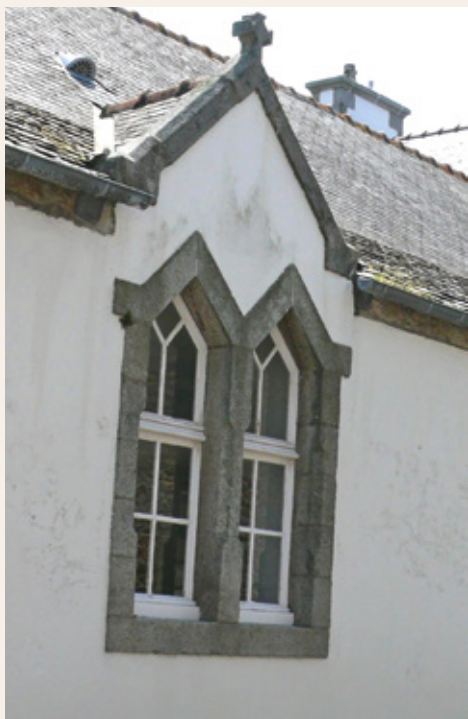
Belle fenêtre double surmontée d'une croix à la salle d'asile, aujourd'hui 3 rue Brizeux.
